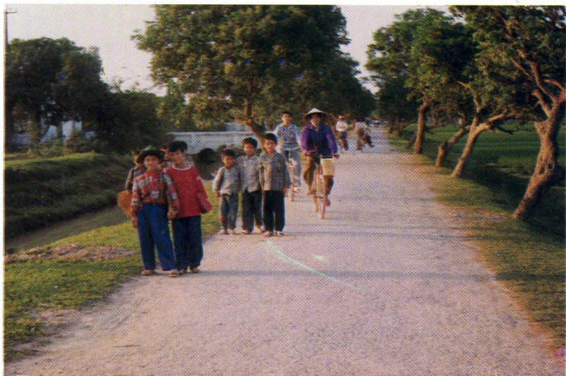
Đường nhựa trục xã – công trình hoàn thành đưa vào sử dụng năm 1995.
